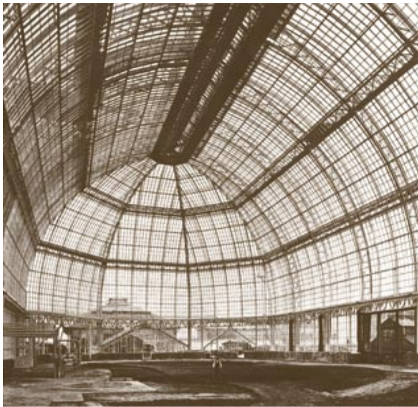
Das Große Tropenhaus im Bau.
